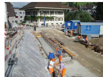
Fundationen Stützmauern Spitalstrasse
