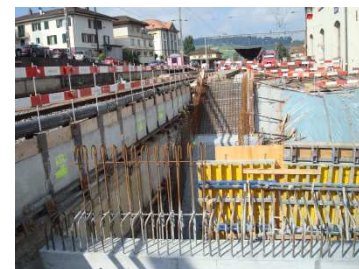
Personenunterführung Ost Sicht Richtung Walkestrasse
