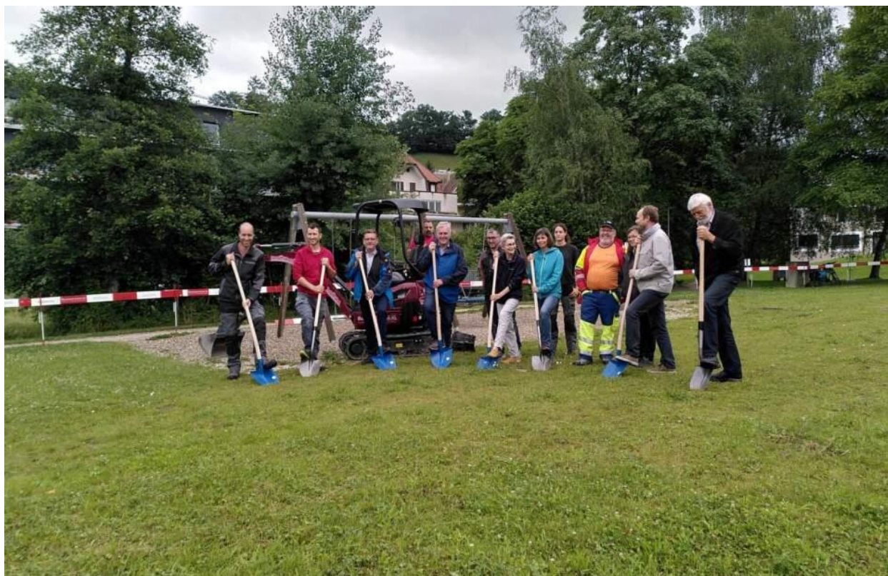
Bild: Spatenstich vom 07.06.2022
