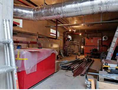
04.11.2023 Montage im Heizraum
