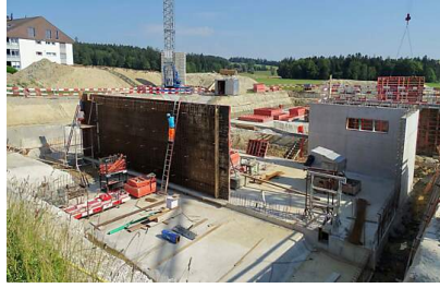
Schalung der Zwischenwand 25.06.2023
