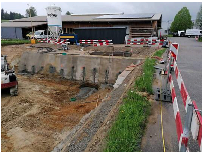
Aushub- und Sicherungsarbeiten 09.05.2023
