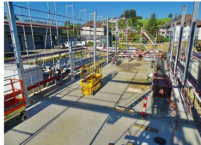
26.09.2023 Konstruktionsaufbau Halle Flückiger Hecht
