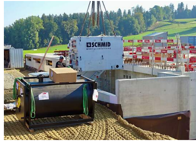
11.09.2023 Einbringen der Heizelemente
