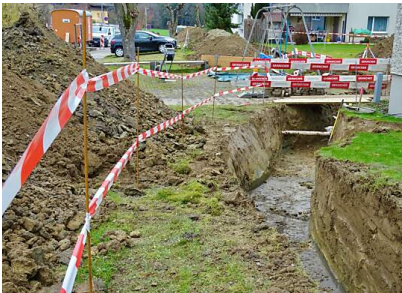
01.03.2024 Graben für Wärmeleitung
