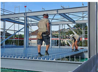
28.09.2023 Halle FH; Bodenprofile montieren
