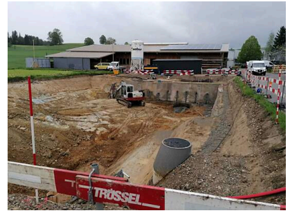
Aushub- und Sicherungsarbeiten 09.05.2023
